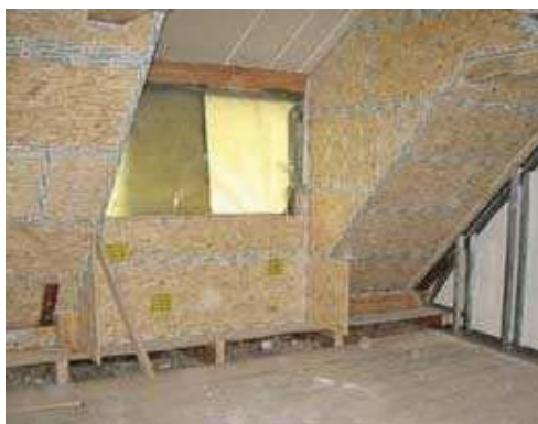
Figure 70. Panneau OSB intérieur comme pare-vapeur (modéré) et étanchéité à l'air également dans le grenier
