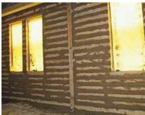
Figure 69. Isolation intérieure avec béton végétal (terre allégée) au rez-de-chaussée
