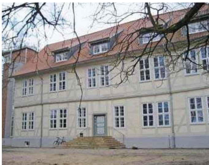
Figure 68. Façade à colombage isolée par l'intérieur (Borsch-Laaks et Simons 2012, 13)
