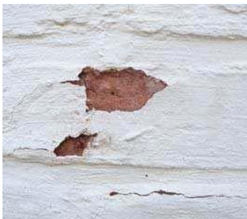
Figure 73. Écaillage sur une nouvelle peinture
